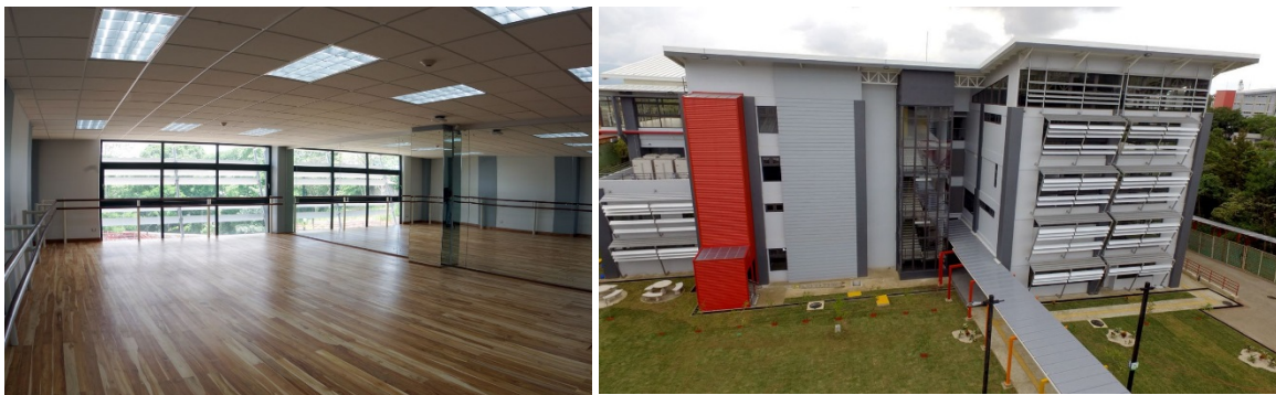
Edificio para la innovación de los aprendizajes y las artes, izquierda aulas de danza y derecha vista este.
