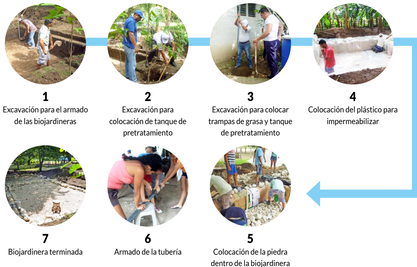
Figura 12. Proceso constructivo de una biojardinería Nota: Elaboración propia por Maritza Marín-Araya (2016-2017).
