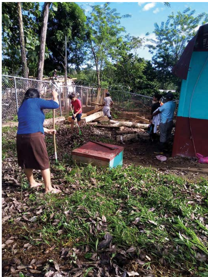
Figura 8. Comunidad La Trocha: trabajando en las mejoras del pozo de agua
