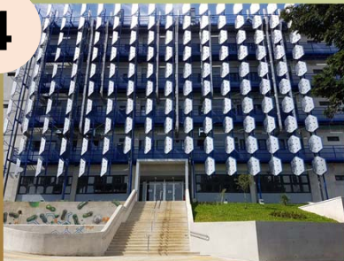
Edificio de Nuevos Procesos Industriales
