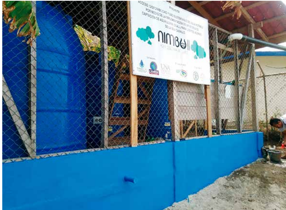
Figura A11. Módulo SCALL de Isla Caballo finalizado y operando. NOTA. IMAGEN PROPIEDAD DE LOS AUTORES, TOMADA EN MARZO DE 2019.
