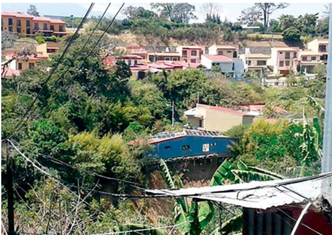
Figura 11. Viviendas con riesgo de deslizamiento en Gira de la Mesa de Gestión del Riesgo de Desastres en conjunto con la Municipalidad de Moravia, Barrio Bosques de Moravia. San José, Costa Rica.
