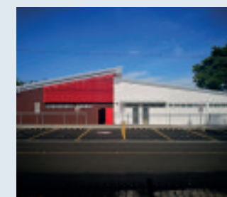
Edificio de biblioteca y laboratorios de CIEMHCAVI, Campus Benjamín Núñez
