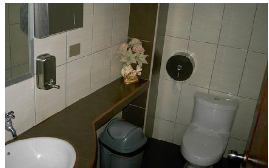
Figura 7. Baño adecuado de un servicio de alimentos.
