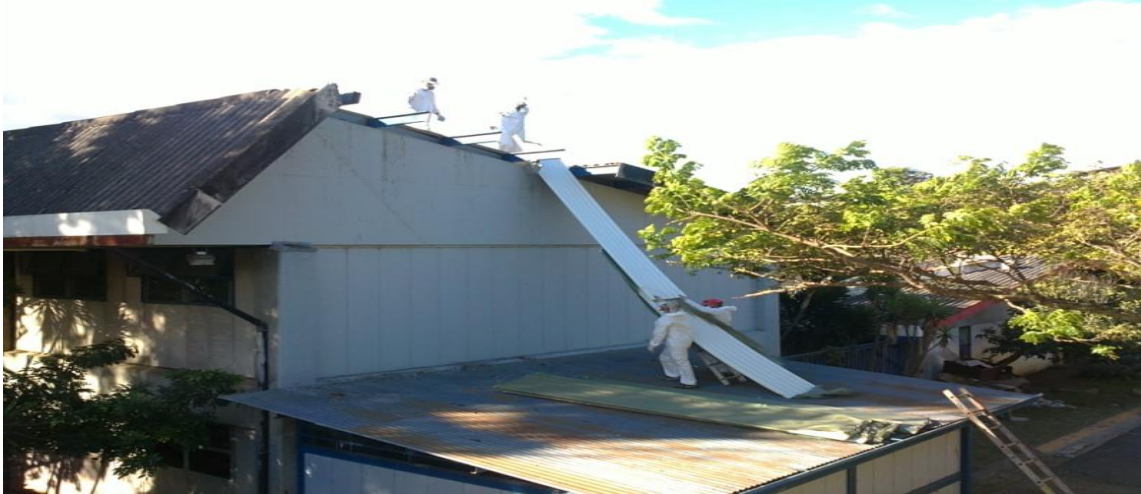
Sustitución de techos de asbesto Foto: Área de Planeamiento Espacial
