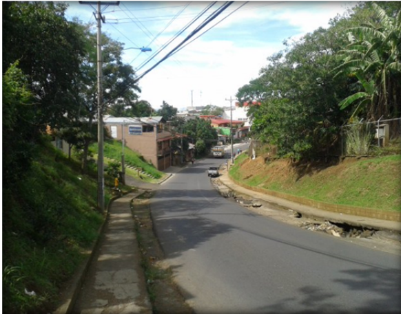
Fotografía N° 9.5. Ejemplo de aceras existentes en el costado Noreste del “Campus Omar Dengo” (MAPG-Noviembre, 2013)
