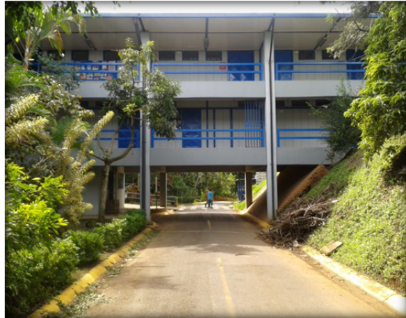
Fotografía N° 9.6. Calle interna en el “Campus Omar Dengo” que dispone de un paso elevado para peatones pero no aceras (MAPG-Noviembre, 2013)
