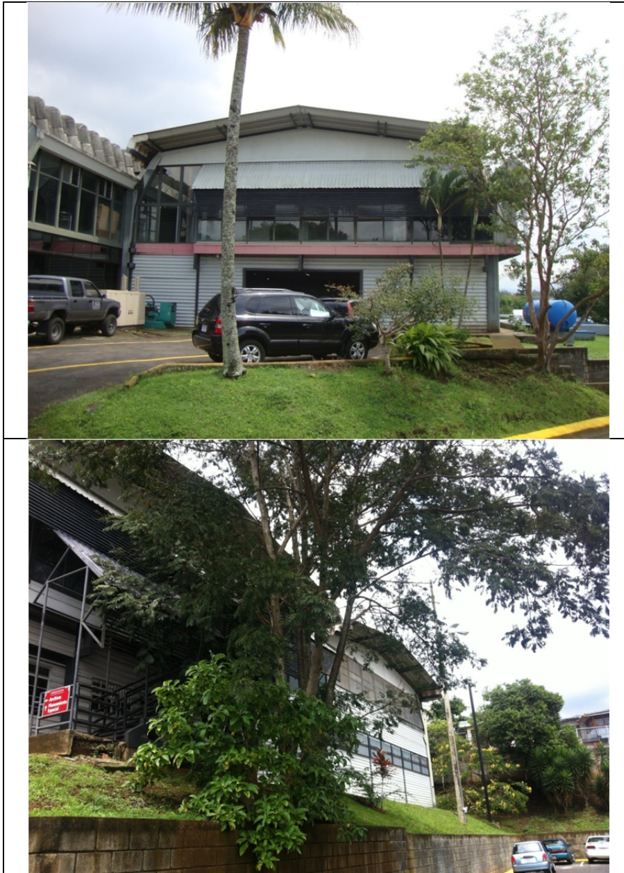
Fotografías 3.1 y 3.2. Vista del sitio en donde se pretende llevar a cabo las obras del edificio de Procesos Industriales.
