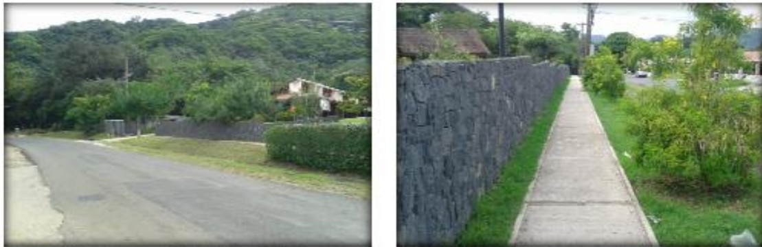
Figura 32. Fotografías de las características de la ruta N°150 y del tipo de tránsito frente al “Campus Nicoya”. Fuente. Geocad, 2015.
