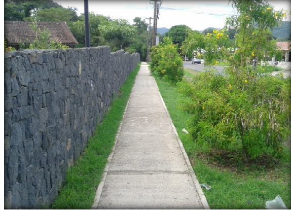
Fotografía 6. Tramo de acera existente en las afueras del "Campus Ncoya" (MAPG-Noviembre, 2013)
