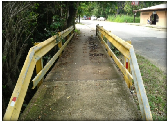
Fotografía 9. Puente peatonal sobre río cercano al “Campus Ncoya” (MAPG-Noviembre, 2013)
