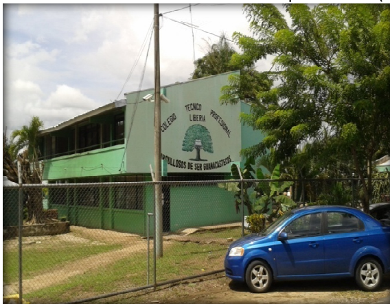
Fotografía 9.13. Instalaciones del “Colegio Técnico Profesional de Liberia”, en las cercanías del “Campus Liberia” (MAPG-Noviembre, 2013)
