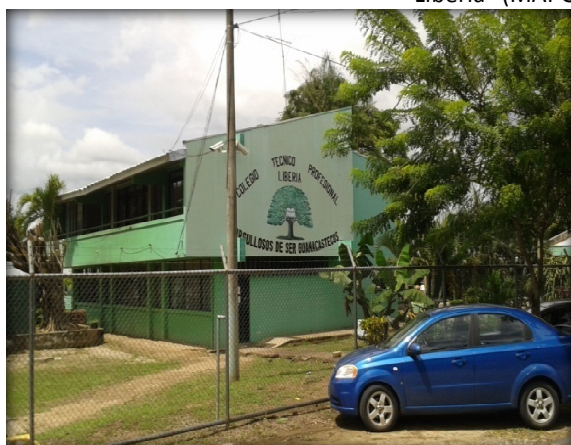
Fotografía 5.10. Instalaciones del “Colegio Técnico Profesional de Liberia”, en las cercanías del “Campus Liberia” (MAPG-Noviembre, 2013)
