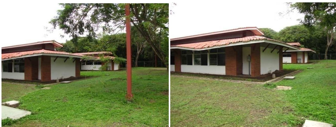
Fotografías 8.7 y 8.8. Área gris existente. Edificio de Obras Deportivas. Liberia, Guanacaste. Fotografía tomada en el mes de octubre de 2013.
