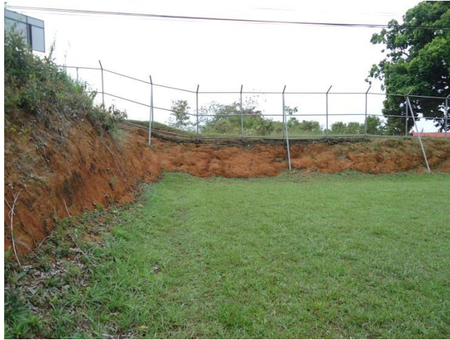
Fotografía N° 2. Afloramientos en el talud que bordea la actual cancha de fútbol de las instalaciones de launa y en donde se proyecta la construcción de las residencias.
