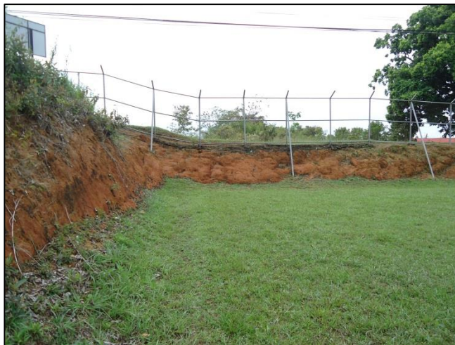
Fotografía N° 3. Afloramientos en el talud que bordea la actual cancha de futbol de las instalaciones de launa y en donde se proyecta la construcción de las residencias.
