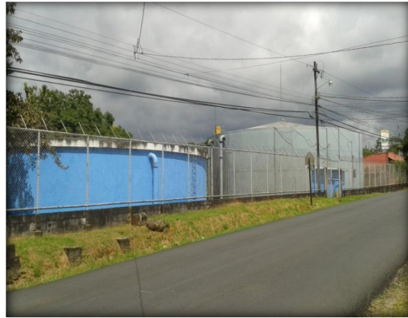
Fotografía 9.11. Tanques de almacenamiento y distribución de agua, ubicados al costado Norte del “Campus” (MAPG-Noviembre, 2013)
