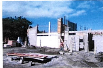
Construcción de los laboratorios.
