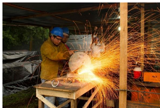
Uso de equipo de seguridad obra Coto
