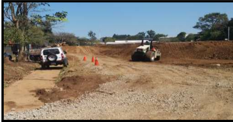
Gestión ocupacional Uso de elementos para señalización y control de polvo mediante uso de lastre
